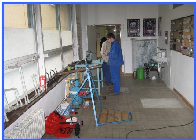
Příprava materiálu instalatéry.
